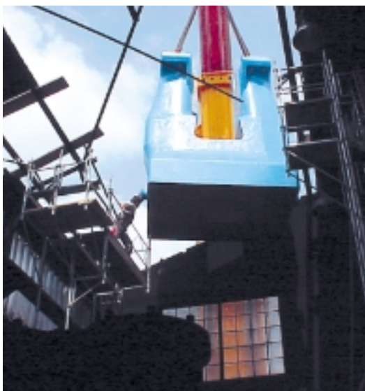
Schweizer „Hochzeit“. Das 160 Tonnen schwere, massive Untergestell des Rekordhammers wird durchs Dach in die Flükiger-Werkshalle abgesenkt.
